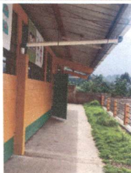
Foto 9: 7 canales y bajadas de aguas pluviales (sustitución de canal de pvc)
