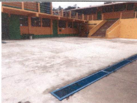
Foto 3: 6 PISO (Reparación de piso de torta de concreto)
