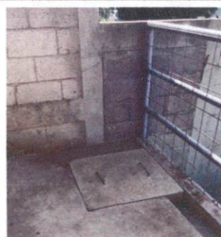
Foto 8: 1.8 Sustitución de cajas de registro
