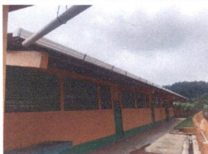
Foto 11: canales y bajadas de aguas pluviales (sustitución de canal pvc)
