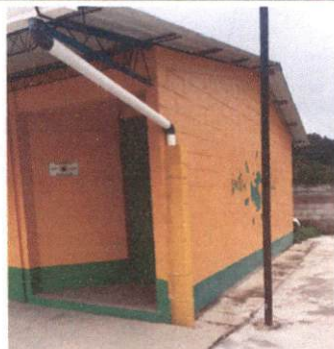
Foto 9: 7 canales y bajadas de aguas pluviales (sustitución de canal de pvc)
