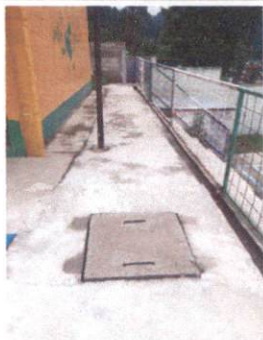
Foto 7: 14 RED DE DRENAJE (14.4 Sustitución de tubería pvc línea principal aguas pluviales)
