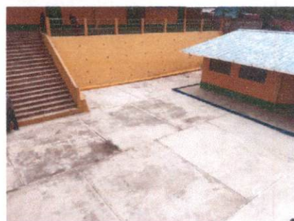
Foto 6: 6 PISO (Reparación de piso de torta de concreto)
