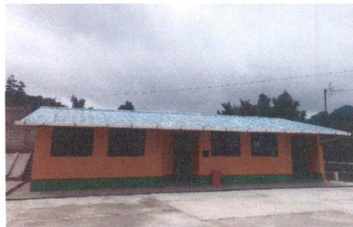
Foto 12: canales y bajadas de aguas pluviales (sustitución de canal pvc)
