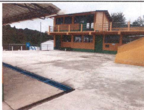
Foto 4: 6 PISO (6.1 Reparación de piso de torta de concreto)
